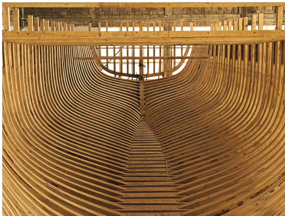
Slika 4. Jedna od posljednjih većih novogradnji u Brodogradilištu Betina (autor: Jadranko Bosna)
