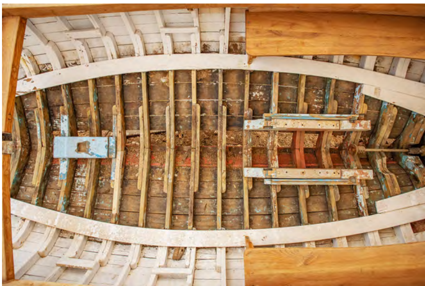
Slika 1. Drveni brod u obnovi (autor: Lovro Vudrag)
